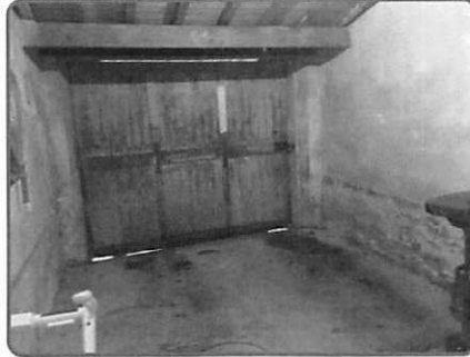
Exterieur Rez de chaussée Garage côté impasse
