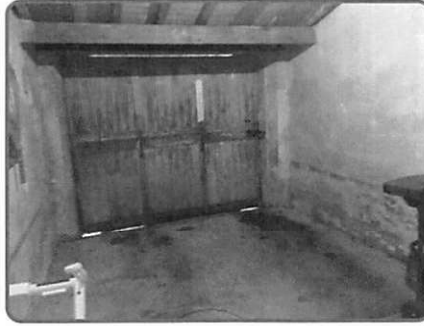
Garage côté impasse
