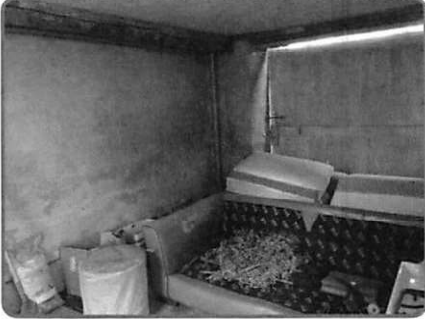
Exterieur Rez de chaussée Garage côté rue
