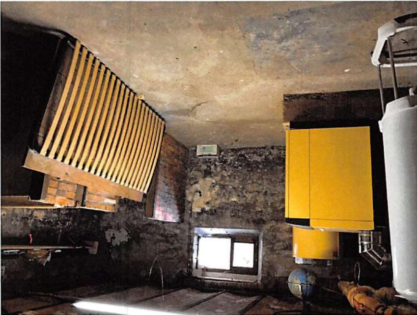
**Pièce à gauche :** dalle cimentée au sol – murs en pierres – briquettes et hourdis au plafond – un escalier en pierre mène à l'extérieur – une vieille porte en bois clos l'escalier – une pompe de relevage installée dans une fosse (le capuchon bleu de la pompe est visible).
