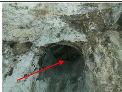
Photo n° PhA001 Localisation : Cave (plafond) Ouvrage : Conduits de fluides (air, eau, autres fluides) Partie d'ouvrage : Conduits Description : Conduit de ventilation amiante ciment Localisation sur croquis : M001
