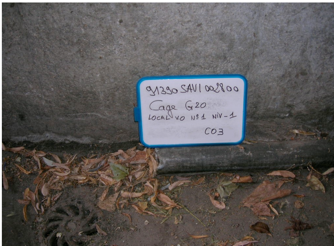
Conduit fibro-ciment n° 3 Bâtiment G20 Local vide-ordures n°1 au niveau -1
