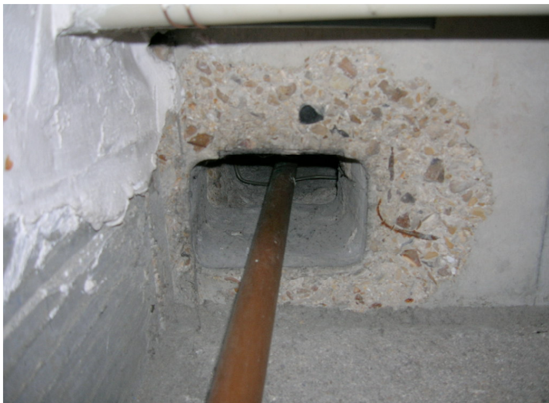
Conduit fibro-ciment n° 10 Bâtiment D10 Gaine technique n°1 au niveau 3
