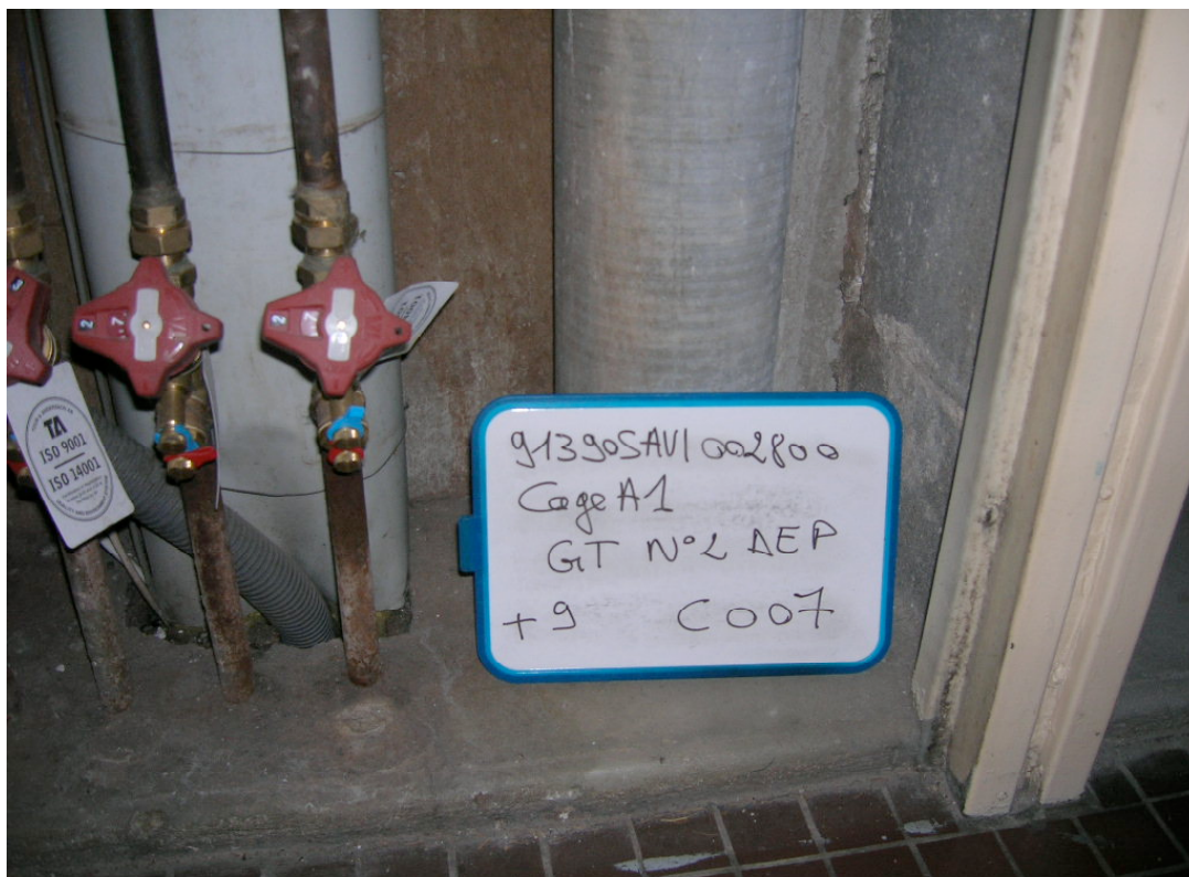
Conduit fibro-ciment n° 7 Bâtiment A1 Gaine technique n°2 au niveau 9
