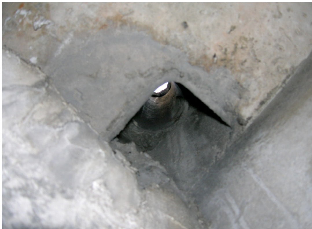
Conduit fibro-ciment n° 8 Bâtiment A1 Gaine technique n°3 au niveau 9
