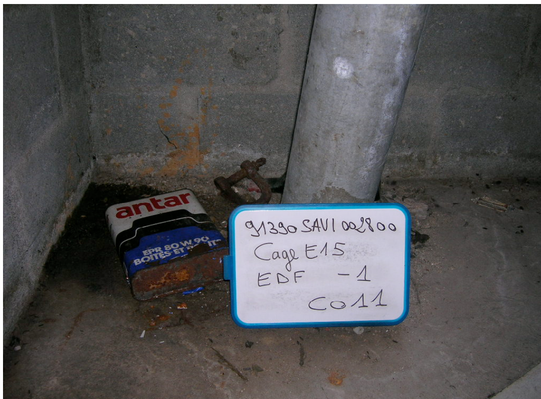
Conduit fibro-ciment n° 11 Bâtiment E15 Local EDF au niveau -1
