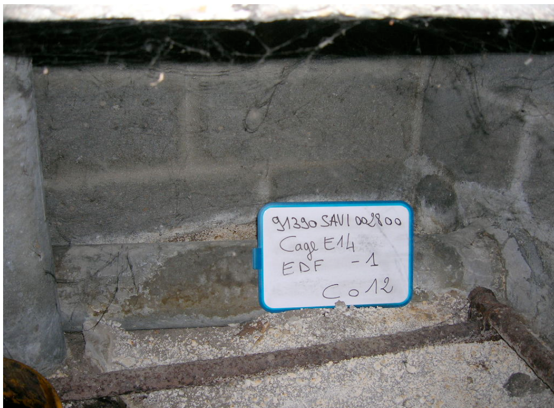
Conduit fibro-ciment n° 12 Bâtiment E14 Local EDF au niveau -1
