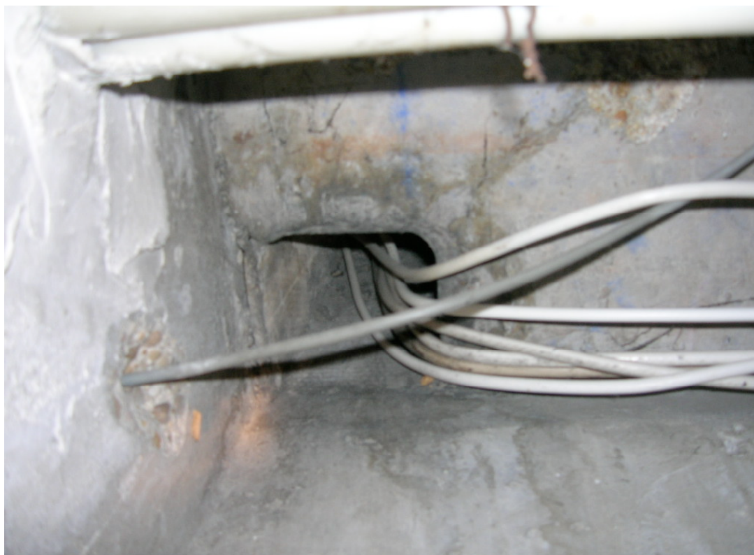
Conduit fibro-ciment n° 9 Bâtiment A1 Gaine technique n°4 au niveau 9
