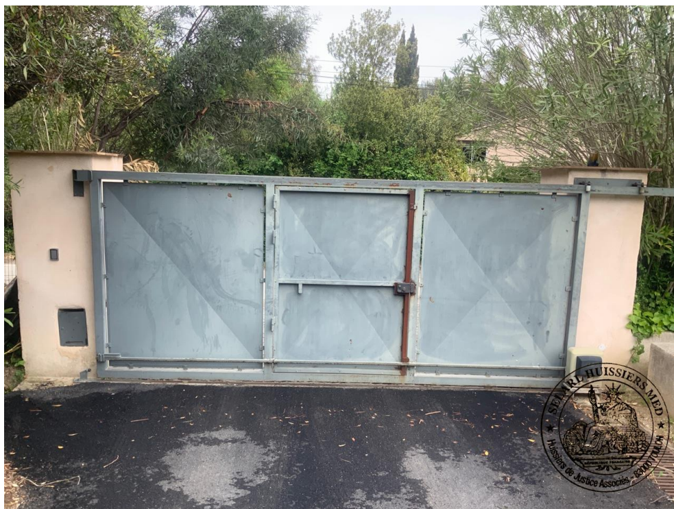
23.PORTAIL ENTREE DESSERVANT LES DEUX PARCELLES
