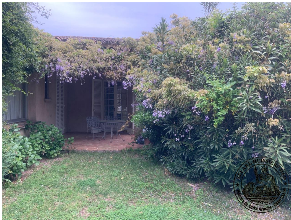
15. ANGLE SUD OUEST
