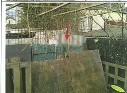
Photo n° PhA001 Localisation : Parties extérieures Ouvrage : 1 - Couvertures, Toitures, Terrasses et étanchéités - Plaques ondulées et planes Partie d'ouvrage : Plaques en fibres-ciment (y compris plaques « sous tuiles ») Description : Plaques en fibres-ciment (y compris plaques « sous tuiles »)
