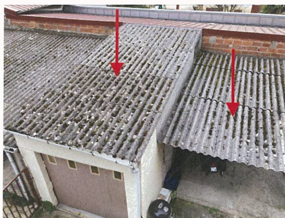
Appentis + garage : couvertures amiante-ciment
