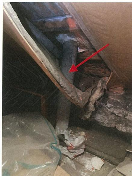
**Grenier : conduit de fluide en amiante-ciment.**
