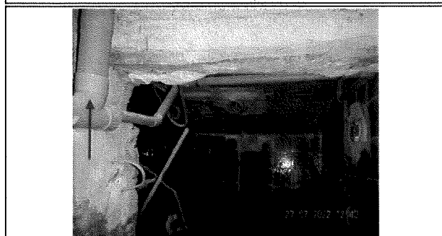
Photo n° Ph009 Localisation : Lgt Maître-RDC - Cuisine; Lgt Maître-RDC - Wc; Lgt Maître-RDC - Wc 2; Lgt Maître-Niv. intermédiaire - Sde; Lgt Maître-1er étage - Wc; Lgt Maître-1er étage - Sde; Lgt Maître-1er étage - Sde 2; Lgt Maître-1/2 niv. supérieur - Sde; Lgt Maître-Sous toit - Grenier; Aile est-RDC - Buanderie; Aile est-RDC - Chaufferie; Aile est-RDC-Appt sud - Séjour/cuisine; Aile est-RDC-Appt sud - Sde; Aile est-RDC-Appt sud - Wc; Aile est-R+1 - Sanitaire; Aile est-R+1 - Sde; Aile est-R+2-Appt nord est - Cuisine; Aile est-R+2-Appt nord est - Wc; Aile est-R+2-Appt nord est - Sdb; Aile est-RDC-Appt nord - Cuisine; Aile est-R+1-Appt nord - Sdd; Aile est-R+1-Appt nord - Wc; Annexes - LT piscine rdc; Annexes-nord - Réduit ss terrasse nord Ouvrage : Conduits de fluides (air, eau, autres fluides) Partie d'ouvrage : Conduits Description : Conduits en PVC
