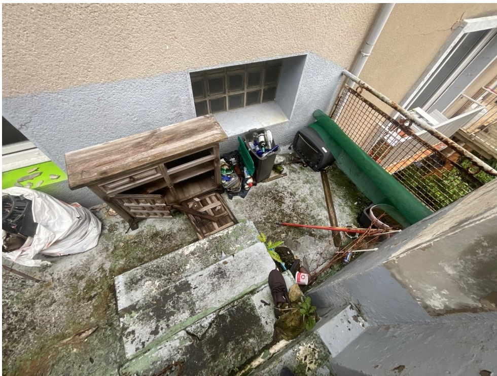
Une terrasse à l'arrière, l'ensemble est en mauvais état
