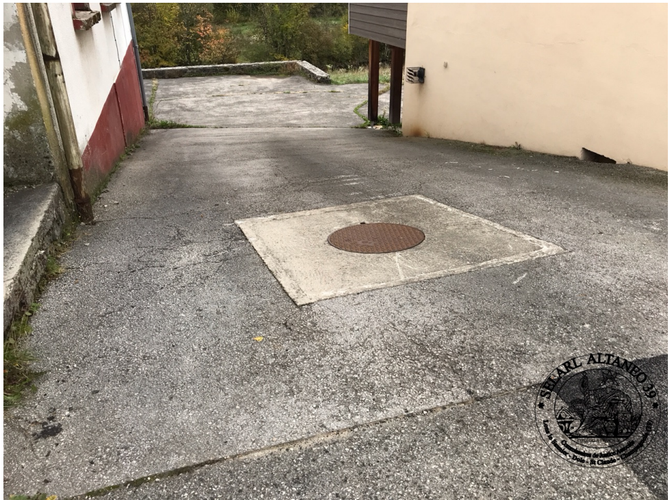
Photographie n°27. Chemin privé appartenant à la propriété située 3, Route de Genève: droit de passage au profit de la propriété située 5, Route de Genève
