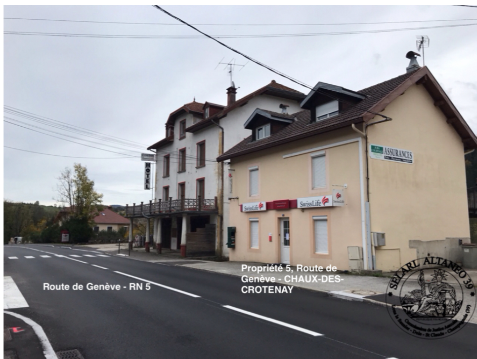
Photographie n°6. Vue du bien immobilier, objet des constatations, depuis la voie publique Axe de circulation SAINT-LAURENT-EN-GRANDVAUX / CHAMPAGNOLE
