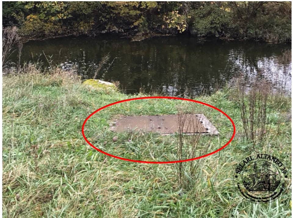
Photographie n°40. Regard à l'extrémité Sud de la propriété
