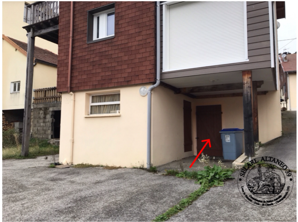
Photographie n°47. Entrée des caves au Sud-est
