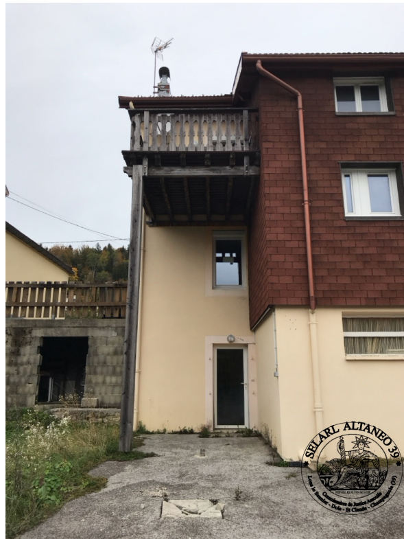
Photographie n°44. Terrasse en bois suspendue
