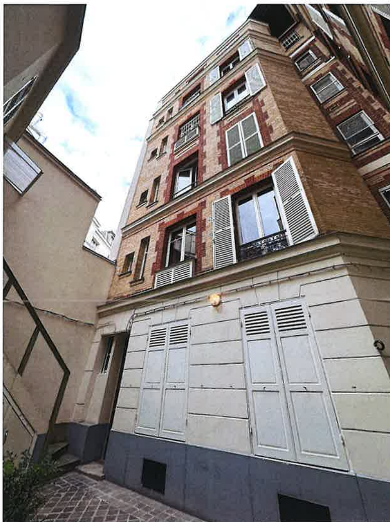
Cour de l'immeuble
