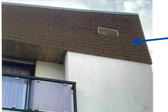
**Extérieur : Bardage de type Shingle susceptibles de contenir de l'amiante**
