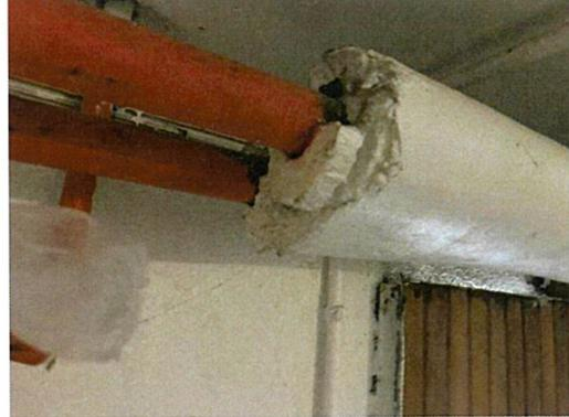
**R -1 : Présence de calorifugeages et enveloppes de calorifugeages susceptibles de contenir de l'amiante**
