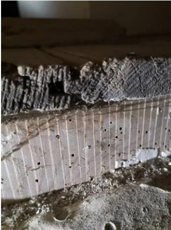
Photo n° PhTer002 Localisation : Combles - Combles 1 Ouvrage : Sol - Plancher bois et chape sèche Parasite : Anobium punctatum (Petites vrillettes) Indices : présence de trous de sortie (présence sur une partie de l'élément)
