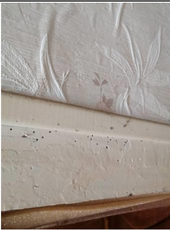
Photo n° PhTer001 Localisation : 1er étage - Chambre 1 Ouvrage : Montant de porte - Bois et Peinture Parasite : Anobium punctatum (Petites vrillettes) Indices : présence de trous de sortie (présence sur une partie de l'élément)
