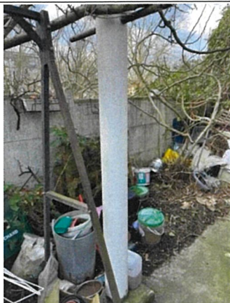
Photo n° PhA002 Localisation : Rez de jardin - Jardin Ouvrage : 4. Eléments extérieurs - Conduits en toiture et façade Partie d'ouvrage : Conduites d'eaux pluviales en amiante-ciment Description : Conduites d'eaux pluviales en amiante-ciment
