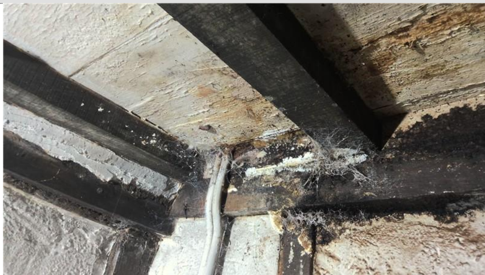
Cuisine(RDC) : Plafond (Bois - Peinture)
