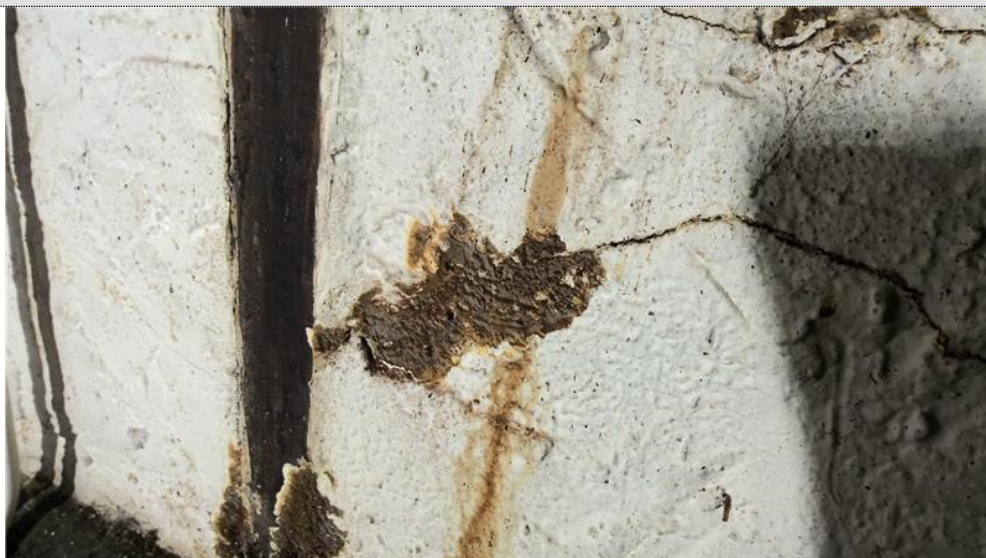
Cuisine(RDC) : Mur (Torchis - Peinture)
