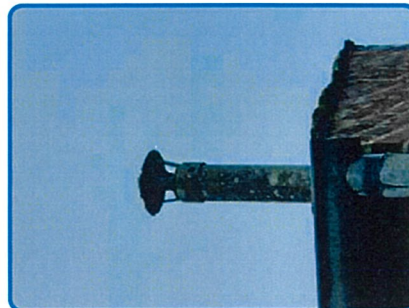
Conduit(s) de ventilation Amiante ciment (dans Dépendance n°2 EXTERIEUR DEPENDANCE)
