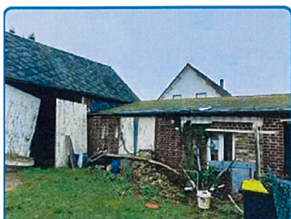
Toiture Accessoires amiante ciment (dans Dépendance n°2 EXTERIEUR DEPENDANCE)
