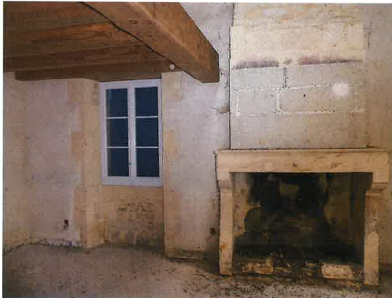
Les réservations pour le futur compteur électrique.
