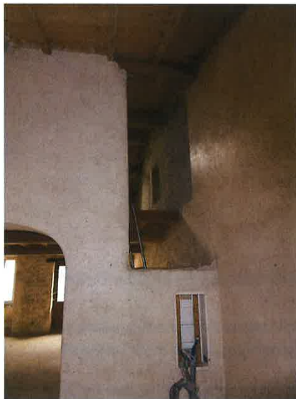
Au niveau du mur comportant l'arche, un grand emplacement prévu pour la trémie de l'escalier avec en-dessous le compteur et des arrivées d'eau.
