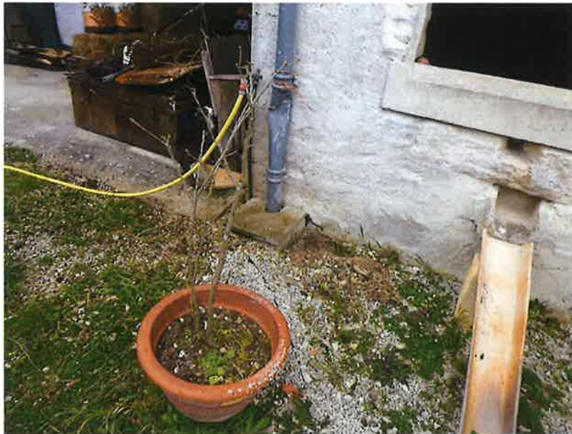
Les regards sont situés devant le local technique.
