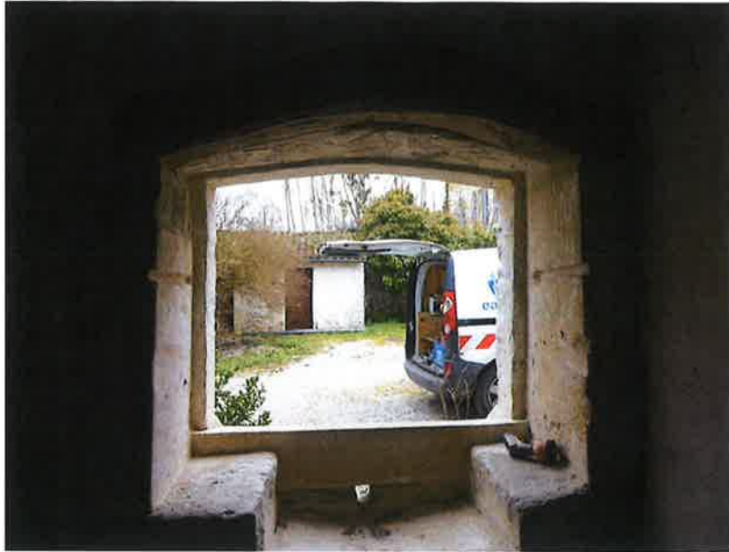
Les emplacements pour les prises électriques.
