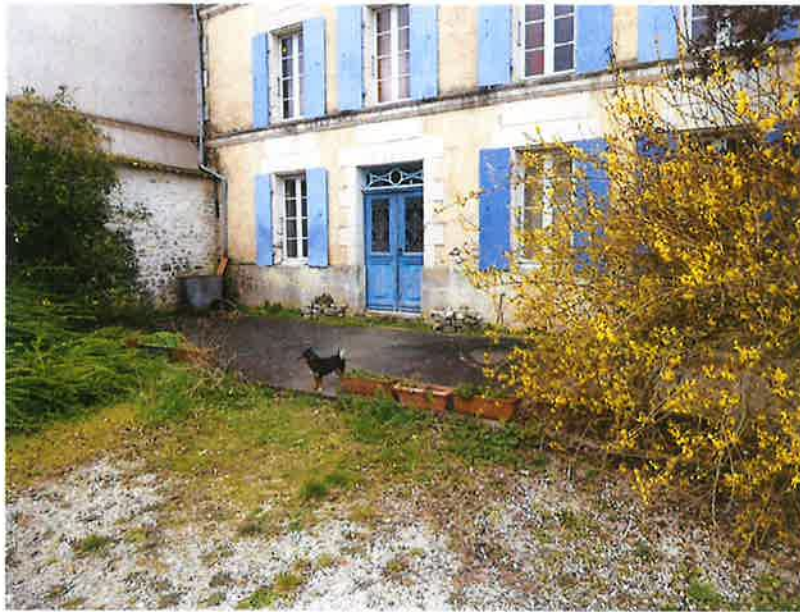
Le pignon droit a été enduit.
