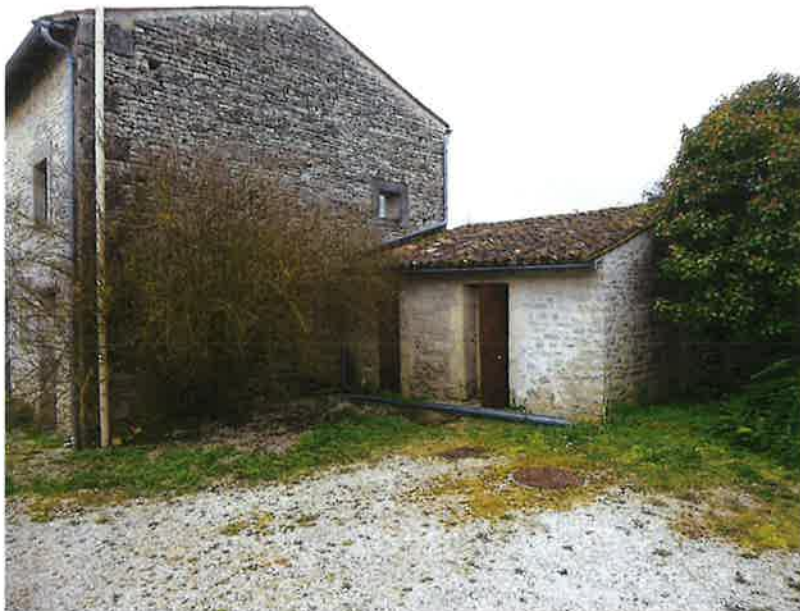
Devant la maison principale, le tampon de la cuve au gaz.
