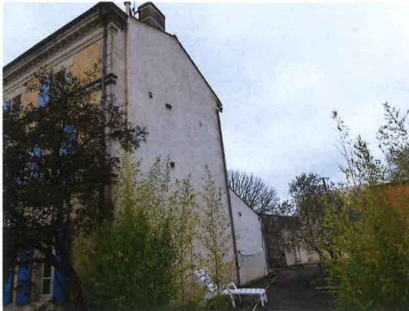
Avec la propriété voisine, on a un grand mur qui a été repris et rejointoyé. Ce grand mur se raccorde avec la dépendance n°2, par un bâti faisant office de local technique.
