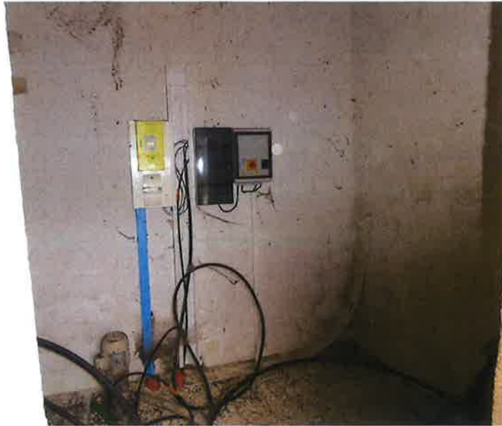
Les robinets de gaz pour l'ensemble des bâtiments.
