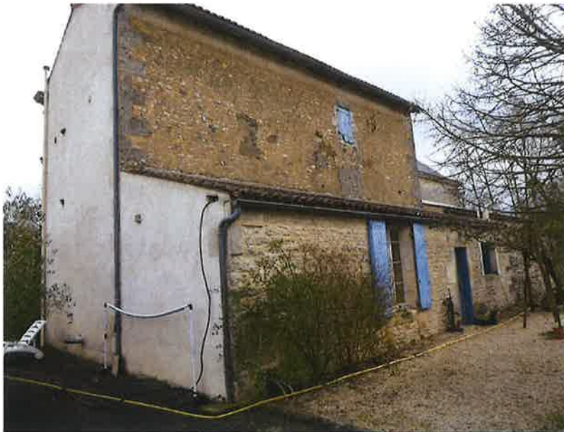
En partie basse, les pierres apparentes ont été intégralement rejointoyées à la chaux.
