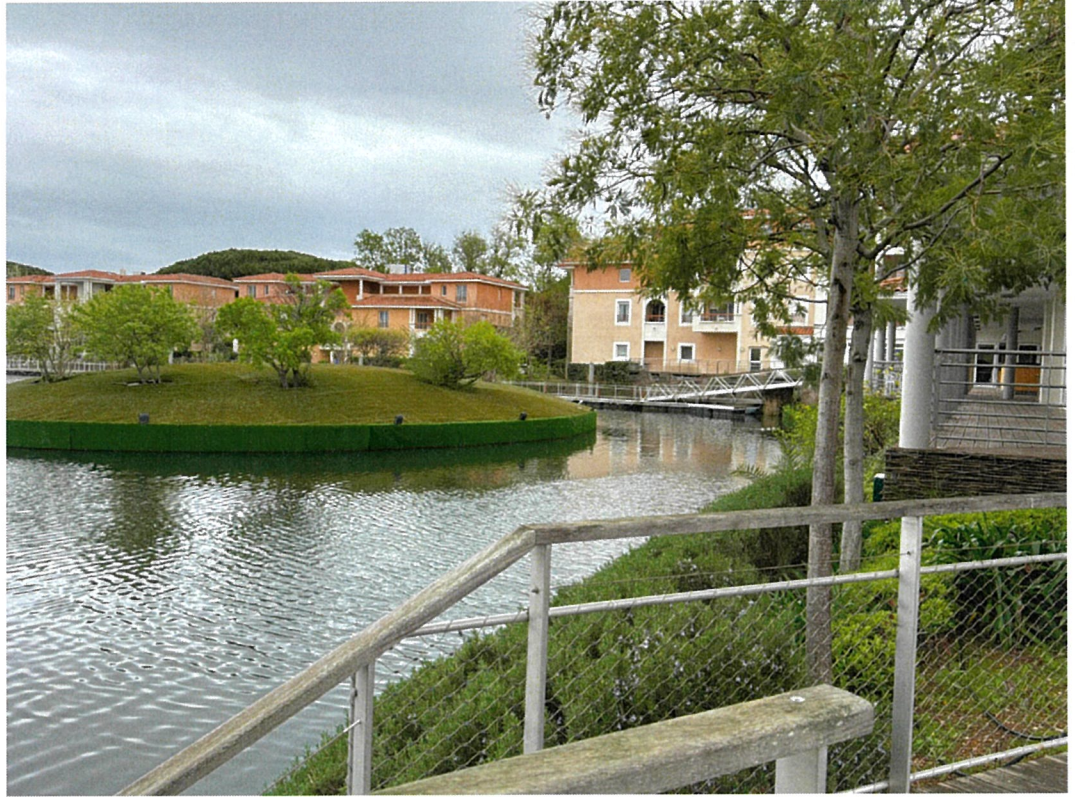
Vue de la passerelle permettant l'accès à la piscine et au terrain de tennis depuis el bâtiment A :
