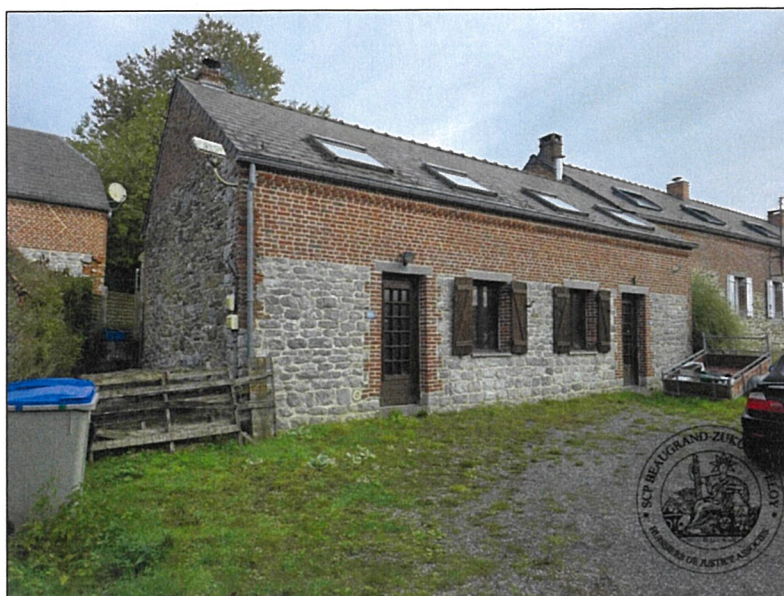
Photographie n°1. Façade de l'immeuble (515 et 521)
