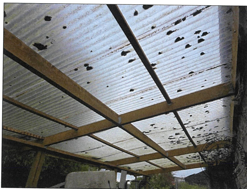
Photographie n°26. Auvent de la terrasse
