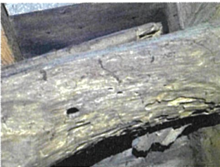
Charpente et couverture
