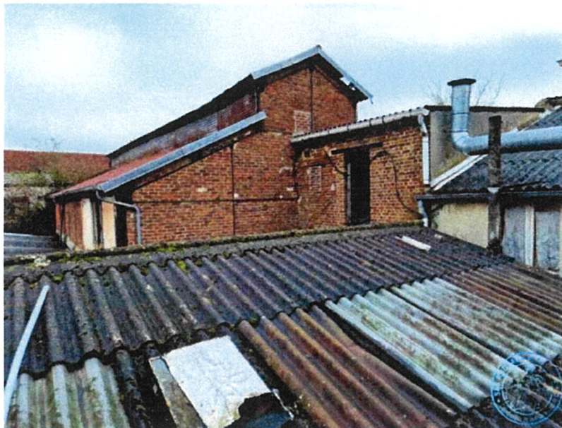
Vue de la façade arrière étage
